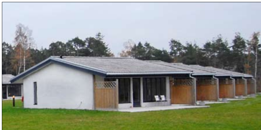
Näst på tur att få solvärme är 15 nybyggda lägenheter, förberett genom en kulvert i marken.
